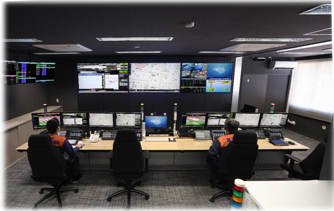
高機能消防指令センター
